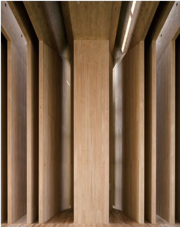
7階 大ホール柱
