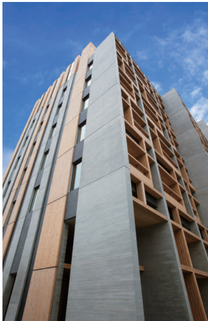
檜の角材でコンクリートと鉄の構造躯体を覆い、安らぎとぬくもりの外観を形成しています。
